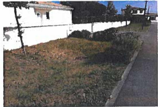
Figure 1 : Exemple de noue d'infiltration n°1
