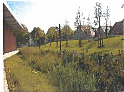
Figure 2 : Exemple de noue d'infiltration n°2
