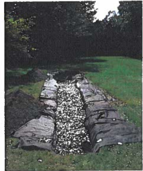
Figure 1 : Exemple de tranchée d'infiltration
